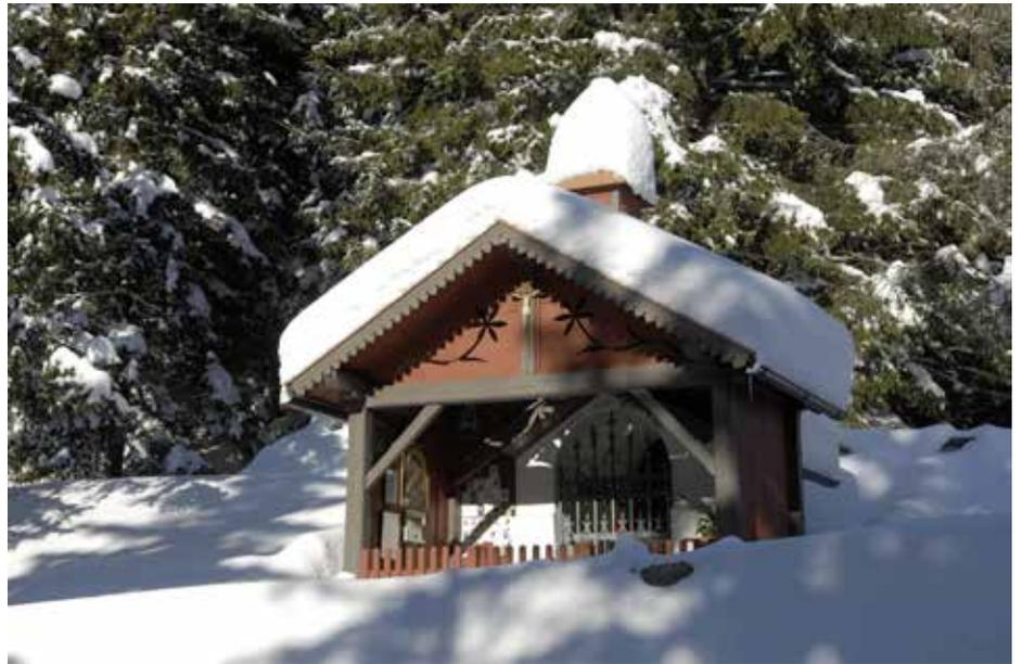
Zuge der genannten Bauarbeiten ist die Kapelle an den Wegrand gerückt, an dem der Verkehr vorbeirauscht. Der Platz vor der Kapelle ist schmal geworden. Nach der Ummantelung des Sockels mit Beton drang Feuchtigkeit nach oben und verursachte Schäden am Holzaufbau der Kapelle. Dadurch wurde eine Renovierung notwendig, von der schon in den 90er Jahren gesprochen wurde, die aber aus folgenden Gründen nicht durchgeführt werden konnte.
