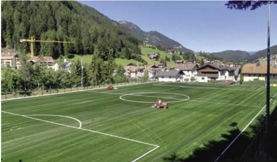
Sul manto sintetico è stato sparso uno strato di sabbia finissima per ottimizzare struttura e tenuta.
